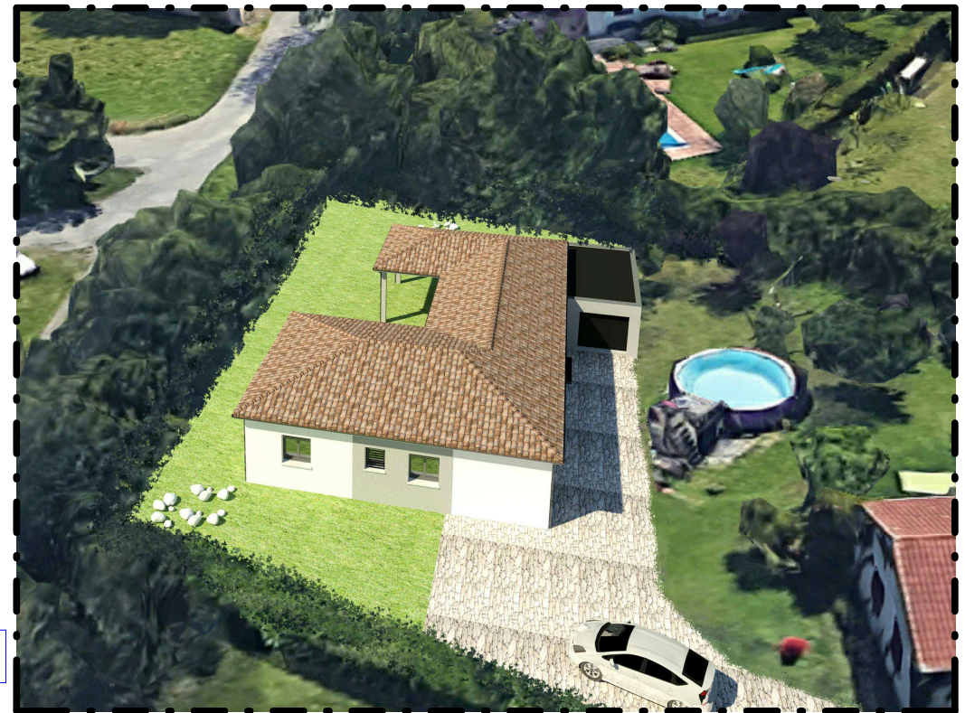
Terrain après construction
