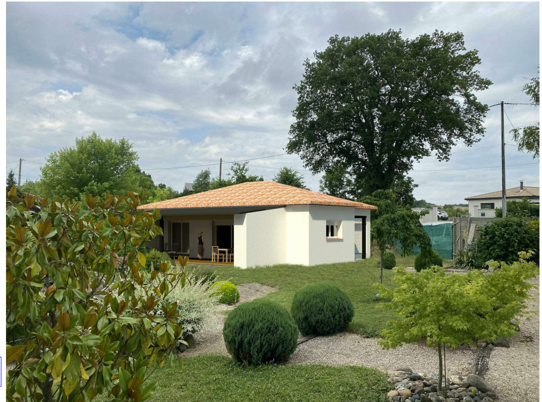
Terrain après construction
